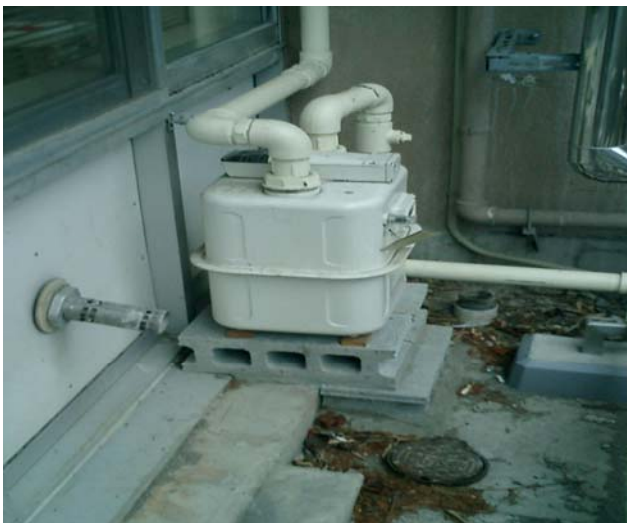
写真-10 ガス計量器および基礎
