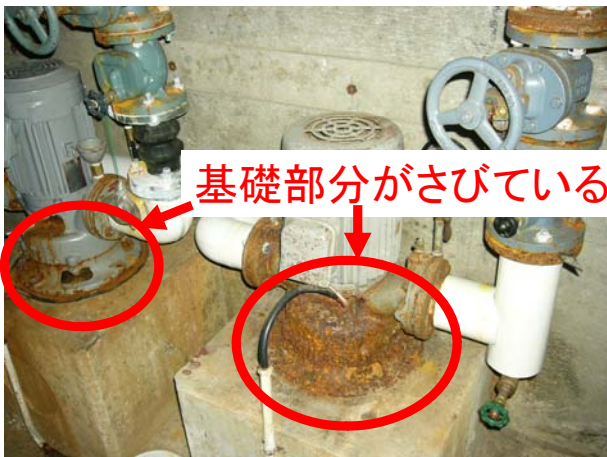
写真5 揚水ポンプ基礎状況
