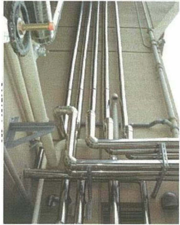
写真-7 外壁部立ち上がり給湯管 給湯管の配管サポート間隔はOK。 サポート架台が貧弱と思われる。
