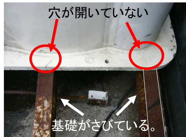
写真6 高置水槽固定状況
