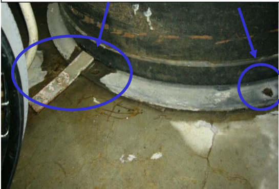
写真5 ボイラーの下部固定状況
