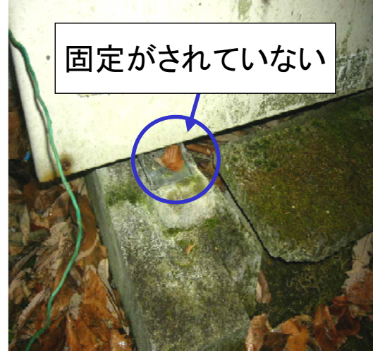
写真6 室外機下部固定状況
