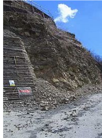
崩落を続ける足尾の山 (赤倉山麓) 2005年3月撮影
