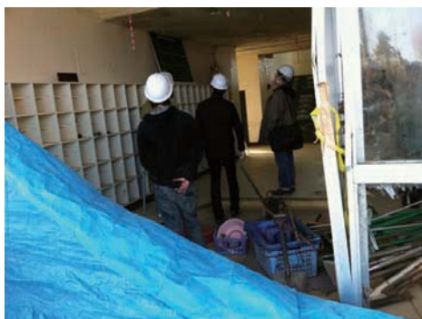
校舎内部の調査
