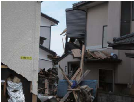
仙台市荒浜の津波被害調査
