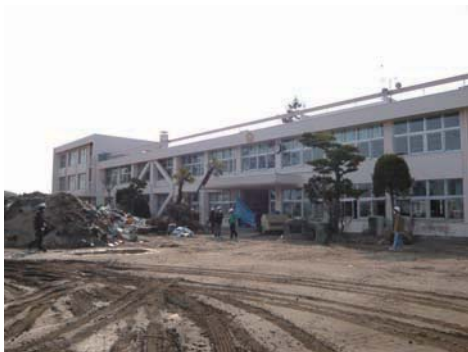
津波被害を受けた小学校。校庭には瓦礫の山
