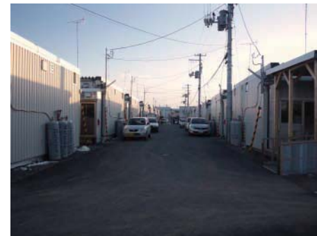
蛇田向陽グランド仮設住宅
