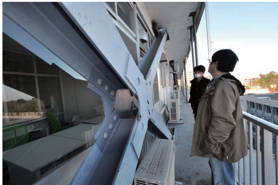
建築学科教員による建物の安全点検。全部の建物を隅から隅まで確認した。写真は建築学科の建物を守った鉄骨ブレース。
