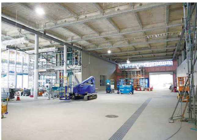
大空間となる1階大型実験室
