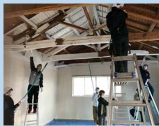
小屋改修 掃除～塗装、自分たちの手で進めています
