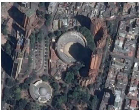
■闘牛場の東側に3棟のレンガの高層アパート群で構成され、1965～1970年に計画された。最高部で37階、117mの高さがある。東側の背後にモンセラテ教会のある丘があり、それに呼応するように建物が構成されている。Googleで航空写真を見ると、大規模な都市の連続した公共緑地をつくろうとした意図が見て取れる。(写真はgoogle mapから)
